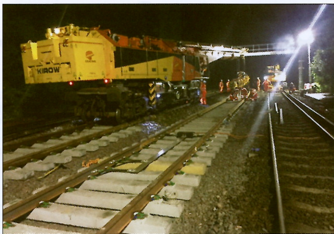
Network Rail est notamment critiqué pour la lenteur et le retard apporté à l'exécution de travaux de maintenance. Ici, des travaux de nuit à Chislehurst
